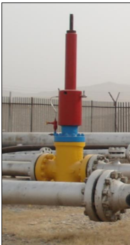
شکل ۱۰: شیر ایمنی سطحی از نوع X و نحوه اتصال مسیر تغذیه آن به وسط بدنه شیر
