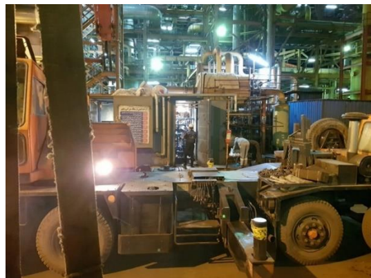
شکل ۶. نمایی از موقعیت کمپرسور گس سیل هنگام تعویض بیرینگ در محیط کارخانه
