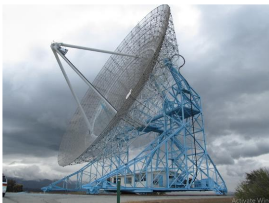
شکل ۵: تصویری از یک بازتابنده سهموی و چرخاننده مکانیکی آنتن
